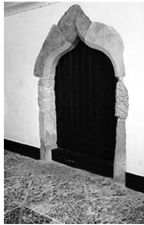
Fig. 10 - Arco contracurvado. Sinagoga de Tomar
