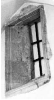
Fig. 5 - Janela de moldura reta. Parede sul da Sinagoga de Tomar
